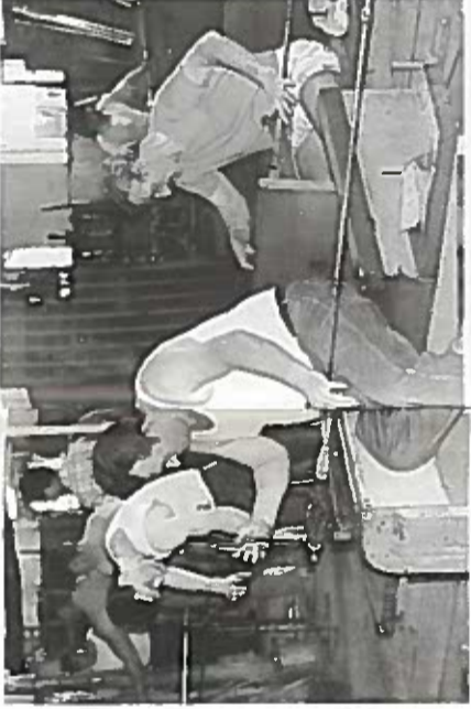
Le chef de place vient de positionner la jambe d'un verre. Derrière lui, le second souffleur façonne le pied d'un autre verre (caché).
